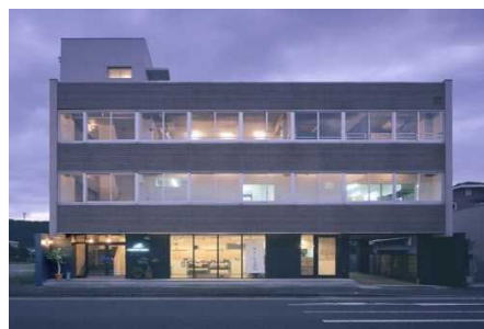
イワシビル 引用：https://iwashibldg.jp/
