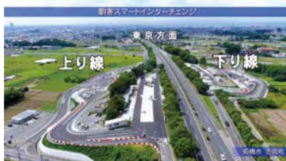
図表2-3-1 大型車対応となった駒寄スマートIC
