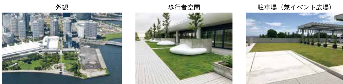
図表1-2-57 パシフィコ横浜ノースの外観と歩行者空間、駐車場に導入された路面緑化技術
