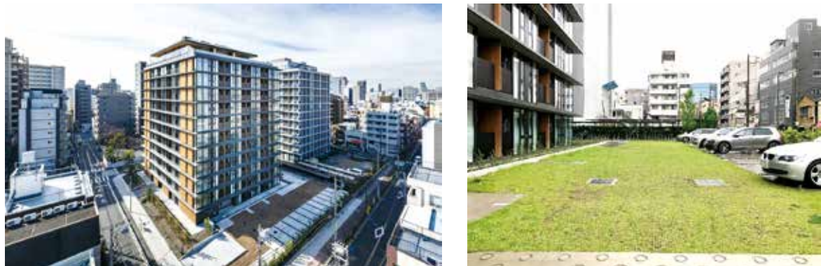
図表1-2-60 フラッツウッズ木場の外観と車路に導入された路面緑化技術
