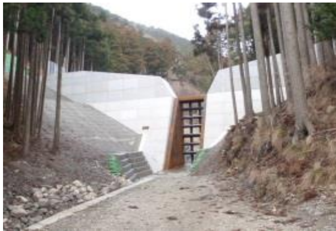
日野谷川堰堤（甲賀市）
