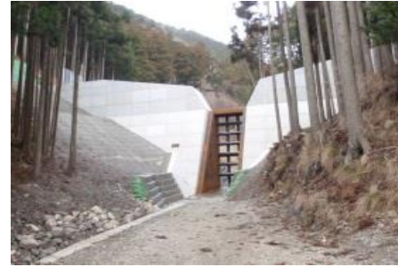
日野谷川堰堤（甲賀市）
