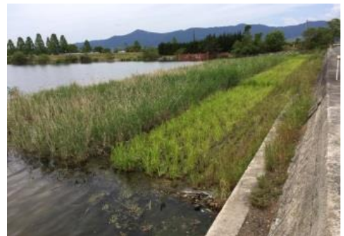
底質改善対策（覆土工・植生工）
