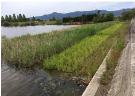
底質改善対策（覆土工・植生工）
