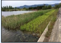
底質改善対策（覆土工・植生工）
