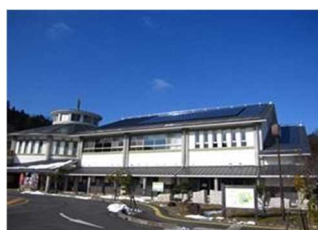
参考機 十二坊温泉ゆらら発電所
