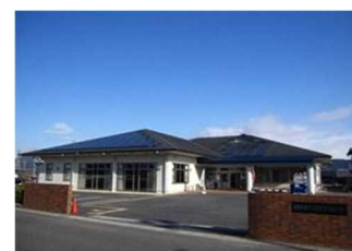
四号機 柑子袋まちづくりセンター発電所
