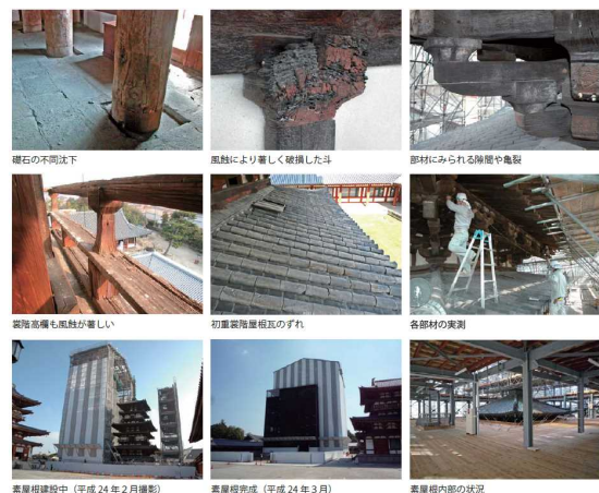
解体修理の状況
