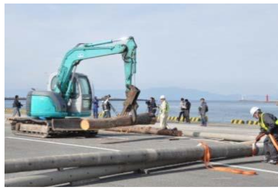
南海トラフ大規模津波防災総合訓練 (広域派遣による道路啓開訓練)
