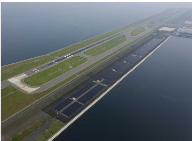
関西国際空港 メガソーラー 提供：新関西国際空港株式会社
