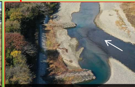
施工済水制工(近景)
