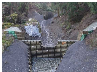
(大津市別所国有林) 治山:溪間工(治山ダム)
