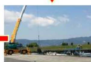
クレーンを用いて岸壁の泊地に陸揚する。
