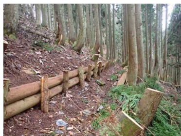
(高島市荒谷山国有林) 保安林整備:本数調整伐・筋工
