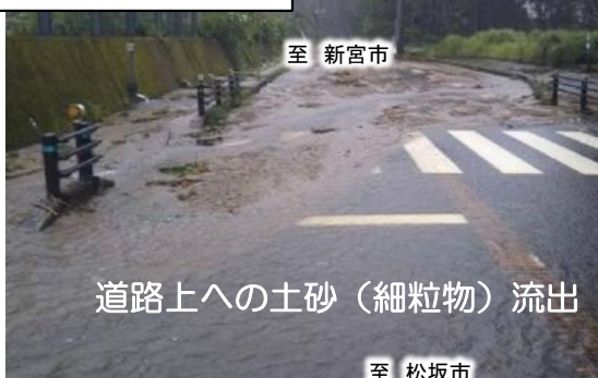
写真②被災状況
