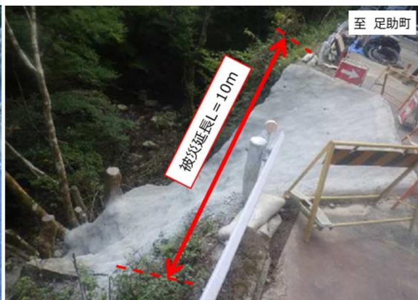
写真② 応急対策後
