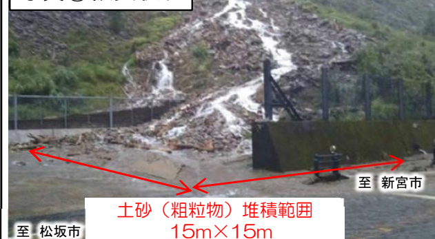
写真①被災状況
