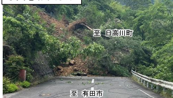
写真②被災状況
