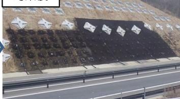
供用中の緊急輸送道路脇の法面において、アンカーの変状が判明したことから、推進費によりアンカーの再設置や地山補強土工による緊急対策を実施。
