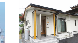
空き家の改修(お試し居住施設)
