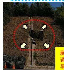
崩壊箇所の浸食深さ及び道路縦断方向への拡大の恐れがあり早急な復旧が必要である。
