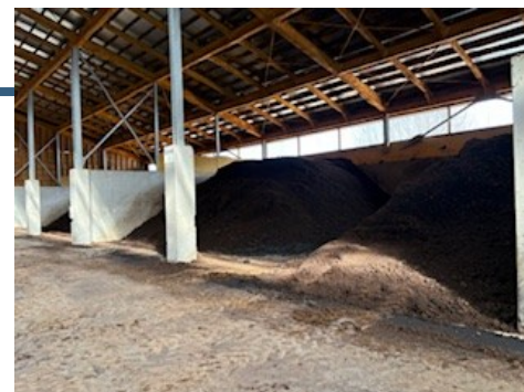
土づくりセンターの内景
