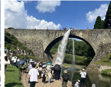
国宝 通潤橋の放水
