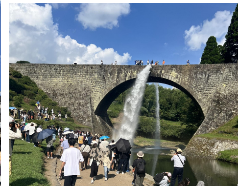
国宝 通潤橋の放水
