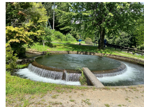
通潤橋へ水を送る円形分水
