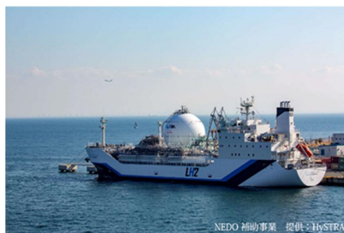
神戸液化水素荷役実証ターミナル
