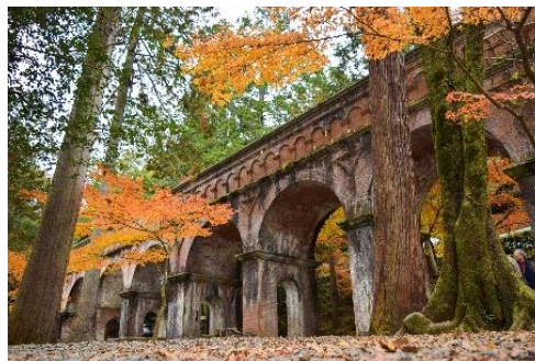
国宝として指定された琵琶湖疏水の施設 (上段：南禅寺水路閣 下段：左からインクライン、第二隧道)
