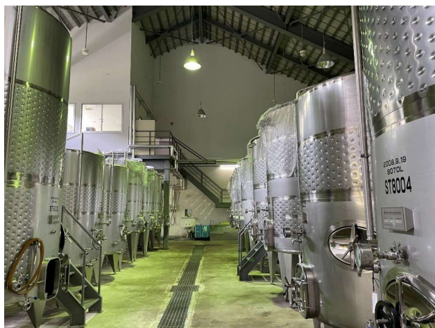
奥尻ワイナリーの工場内
