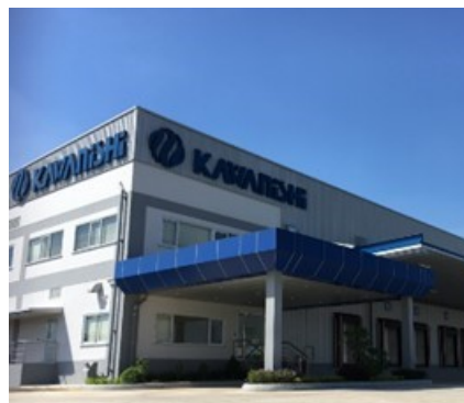
案件例①: インドネシア冷凍冷蔵倉庫整備・運営事業(川西倉庫)
