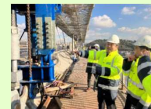
補修工事中の第2ポラス海峡大橋の視察
