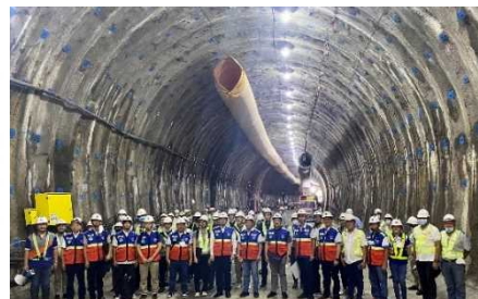
建設中のトンネル内部の様子
