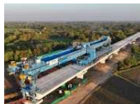
高速鉄道の高架橋工事 (写真提供：NHSRCL)
