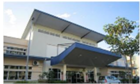
マレーシア・ポートクラン VTS 管制官訓練センター
