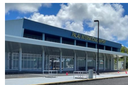
完工後のターミナル
