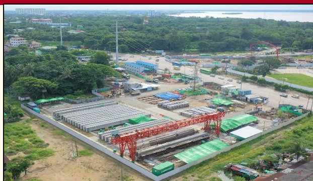
PC-I 桁製作ヤード
