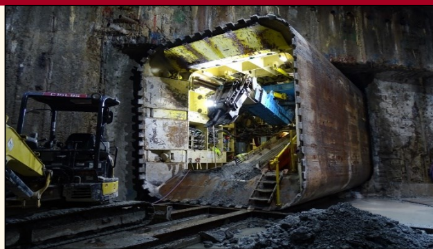
開放型矩形シールド機の到達状況写真(歩行者トンネル)
