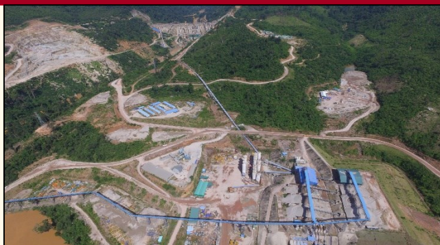
コンクリート生産・運搬設備
