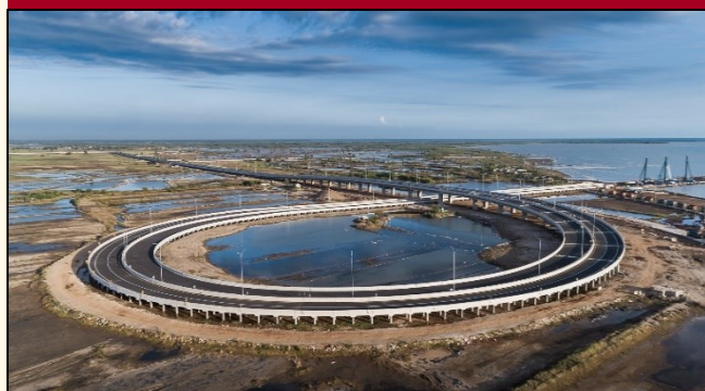
フライオーバー ループ部竣工写真
