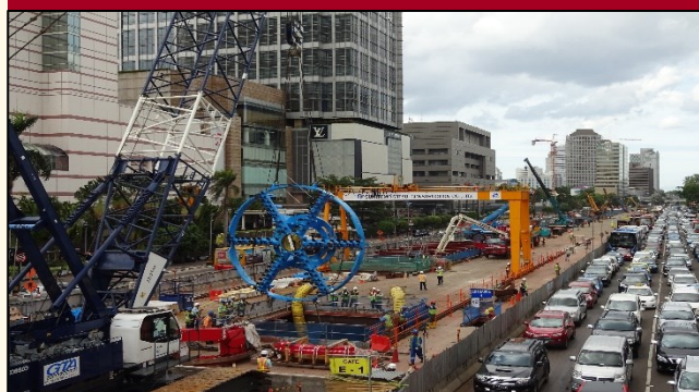
BHI駅 シールド機組立状況
