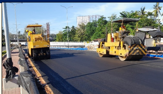
アスファルト舗装施工状況
