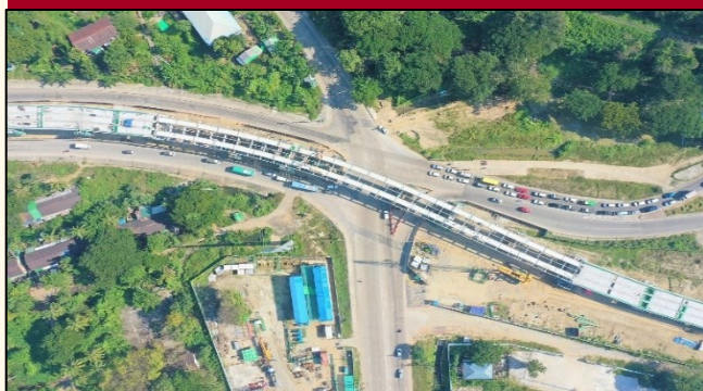
鋼箱桁架設状況
