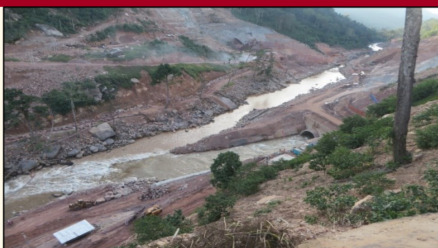
転流後状況 (Outlet側)
