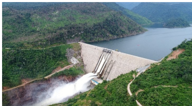
主ダム稼働風景
