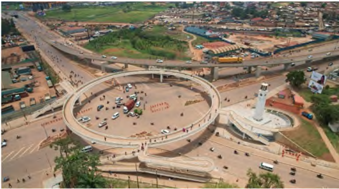
鋼製歩道橋3橋（円形歩道橋）
