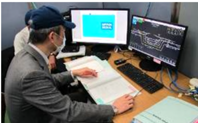
電子連動装置の設置
