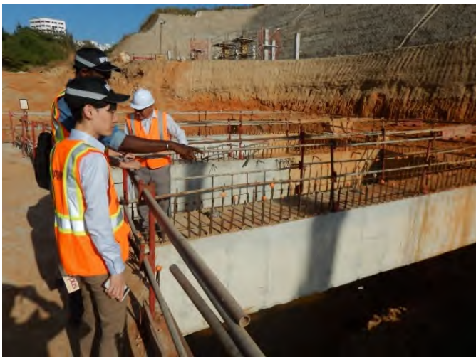
現場確認の様子
