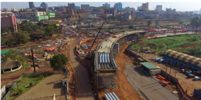
高架橋建設の様子
