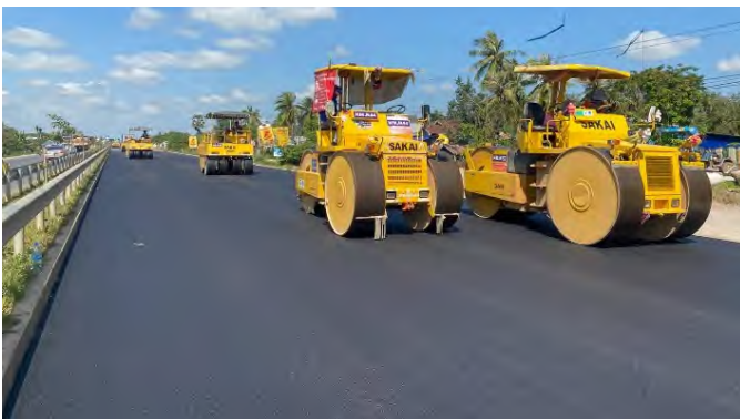
舗装密度98%を達成した卓越した作業風景
