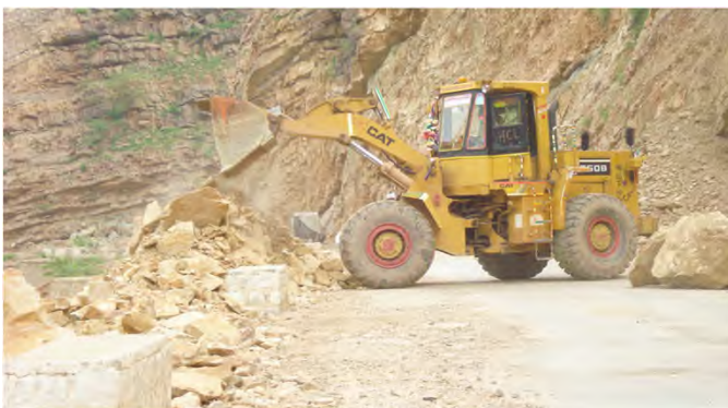
ショベルカーによる道路復旧作業
