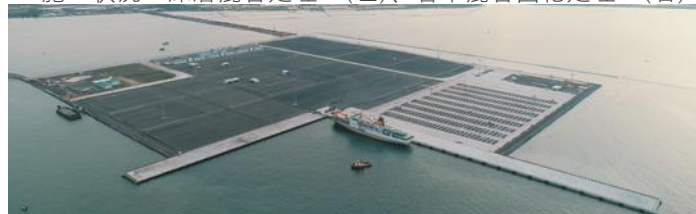
工事完成時全景
