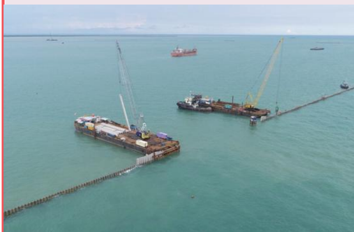
コンクリート矢板打設
