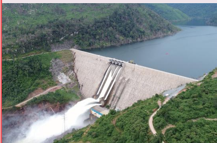
主ダムおよび主発電所
