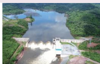
主ダムおよび主発電所
