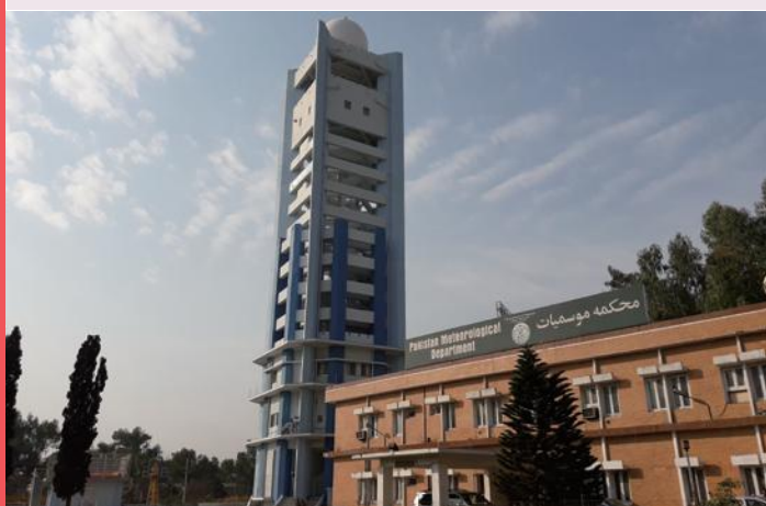
気象レーダー塔と発注者既存建物
