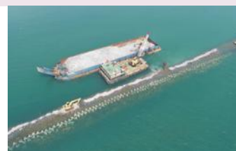
捨石投入均し
