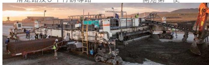
大型フィニッシャーによる滑走路舗装施工状況
