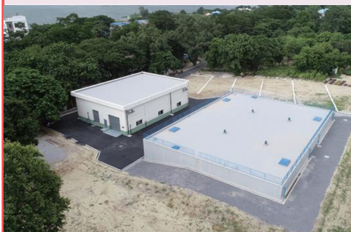
配水ポンプ場
