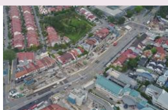
施工状況全景
