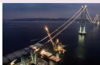
FCによる補剛桁架設状況
