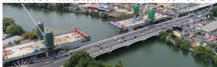
張出し施工状況
