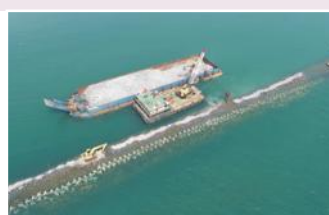
捨石投入均し
