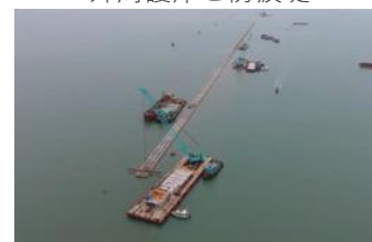
防波堤作業状況遠景
