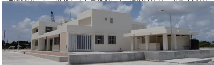
竣工時 管理荷捌き棟
