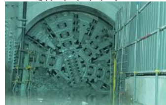
シールドトンネル貫通
