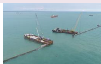
コンクリート矢板打設
