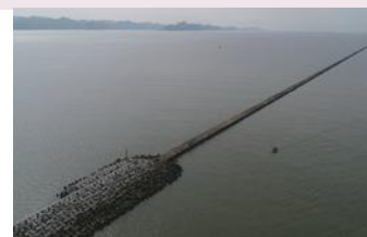
外周護岸と防波堤
