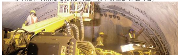
トンネル掘削現場
