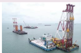
施工状況：深層混合処理工（左）、管中混合固化処理工（右）
