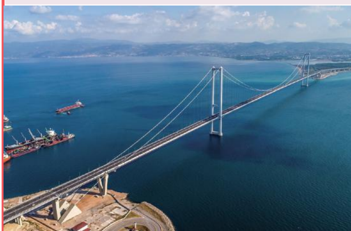
オスマン・ガーズィ橋全景
