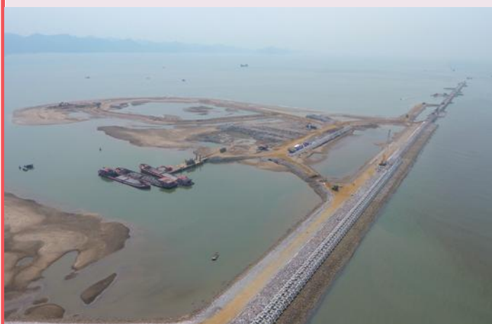
外周護岸施工①
