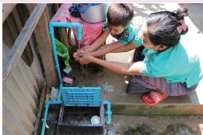
各戸給水状況
