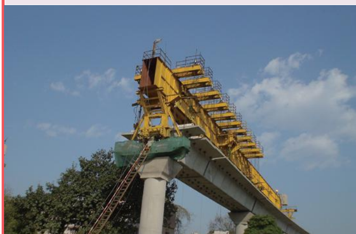
デリーメトロ 高架橋架設
