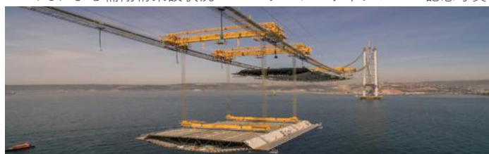
LDによる補剛桁架設状況
