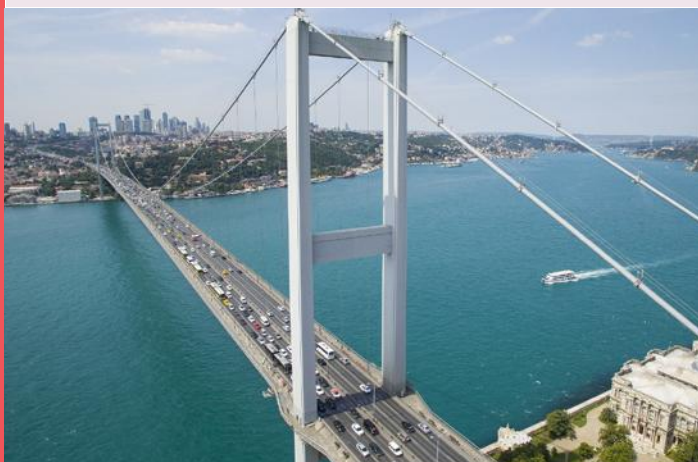
ボスポラス橋全景(1)
