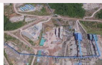
逆調整ダムおよび逆調整発電所
