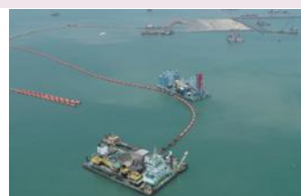
施工状況：深層混合処理工（左）、管中混合固化処理工（右）
