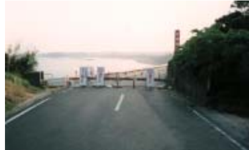
越波や施設災害により通行止めとなり、生活に支障が発生
