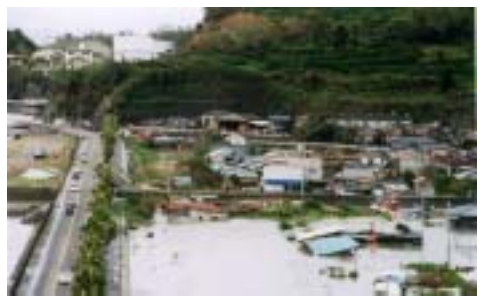
高潮による被害 平成11年台風18号による被害 (熊本県不知火町)
