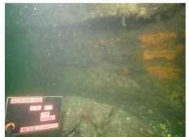
写真-2 損傷と剥落したCo
