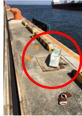
③岸壁照明の破損
