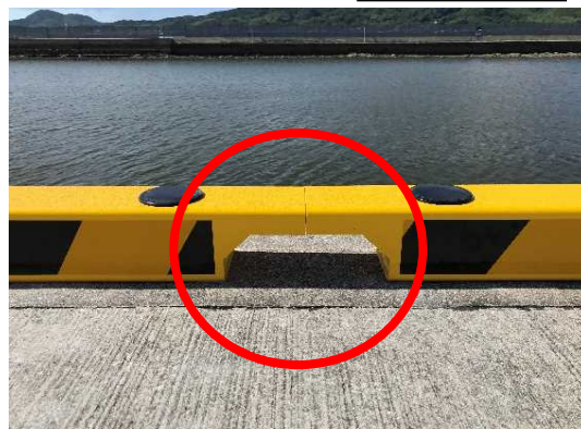
②雨水を逃がす為のトンネル
