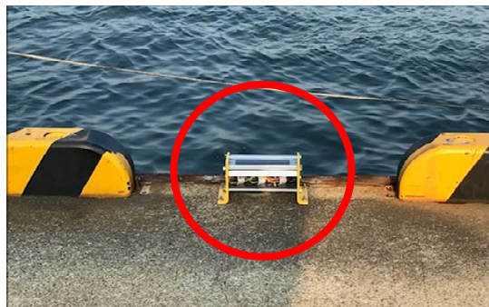
④新設岸壁照明の車止めとの隙間
