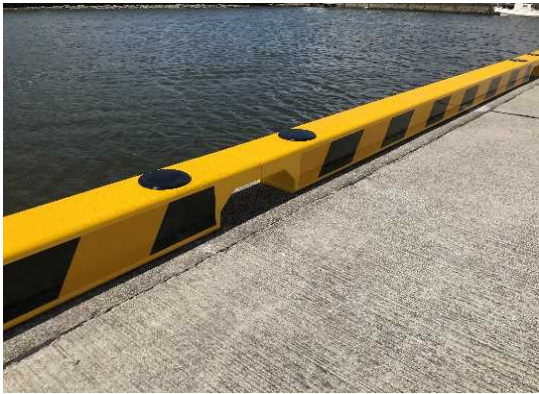
①車止めに隙間無くフラット
