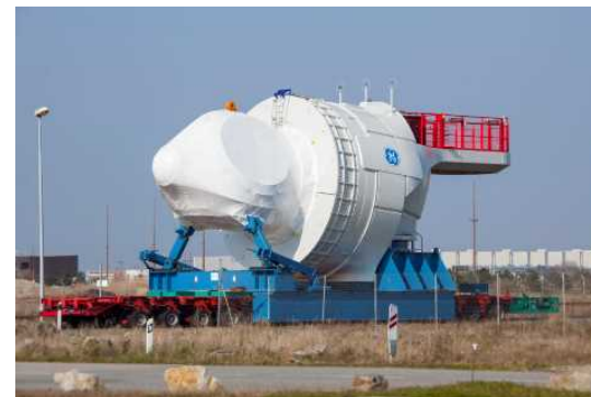
○資機材搬送、積出の様子
