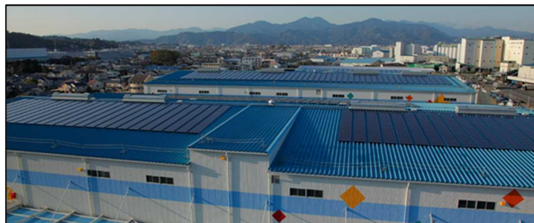
図 19: 清水港の倉庫上における太陽光発電導入事例
