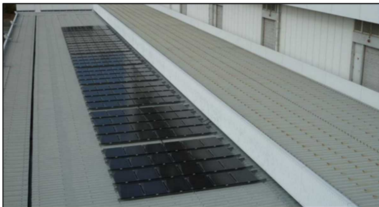
図 17:神戸港の荷捌場上における太陽光発電導入事例
