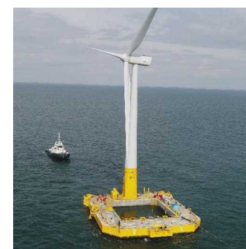
7.完成した浮体 を曳航、設置
