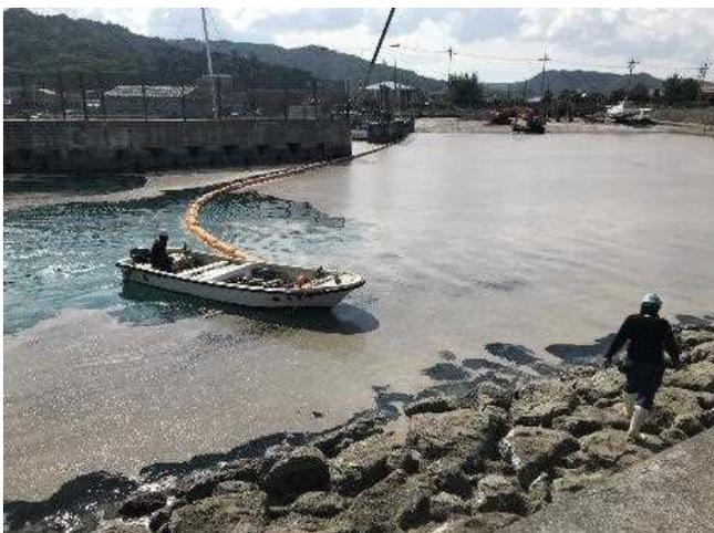
参考写真②-2:汚濁防止膜での軽石の集積
