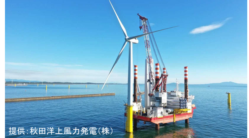
SEP船による海上施工の様子(能代港・秋田港内)
