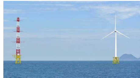
響灘【着底式】 2013 日本製鋼所 2MW
