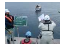
水中スタッフによる施工水深の確認
