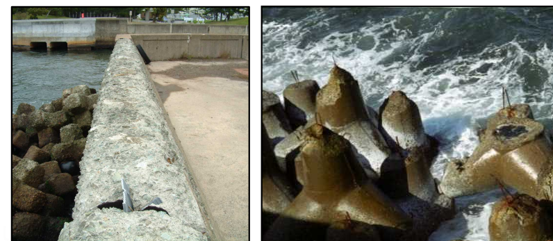
剥離・損傷
