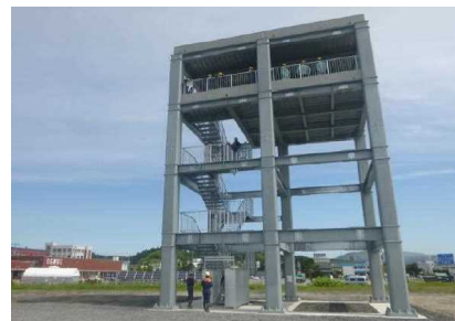
津波避難タワー(船川港)
