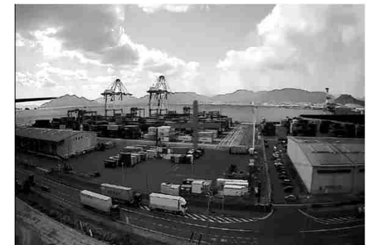
ドローンによる撮影画面
