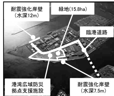
基幹的広域防災拠点(川崎港)
