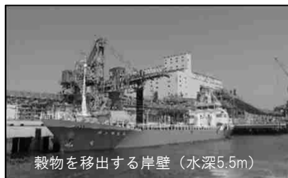
[社会資本整備総合交付金] 地域産業の基盤となる岸壁等の整備（水島港）
