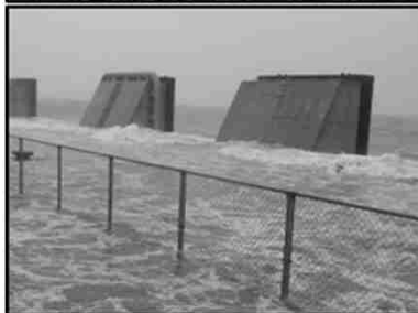
高波で浸水した フェリーターミナル
