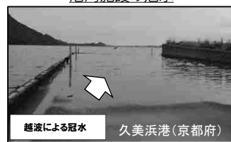
港湾施設の冠水
