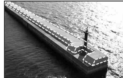
[防災・安全交付金] 津波対策として防波堤高上げ（湯浅広港）
