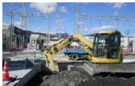
変圧器基礎工事
