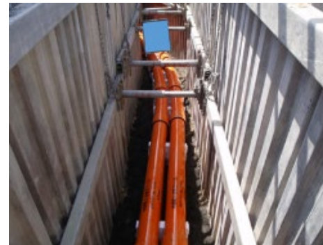
管路工事(据付)
