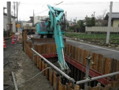
管路工事(掘削)
