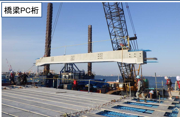
横浜港臨港道路(南本牧はま道路)緊急復旧工事 【京浜港湾】
