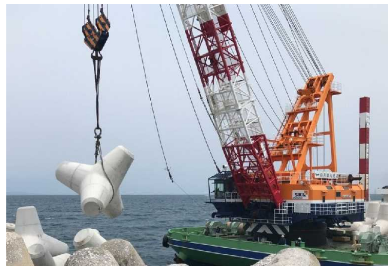
消波ブロック据付
