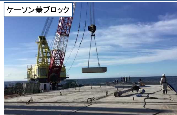
鹿島港外港地区南防波堤築造工事 【鹿島港湾】
