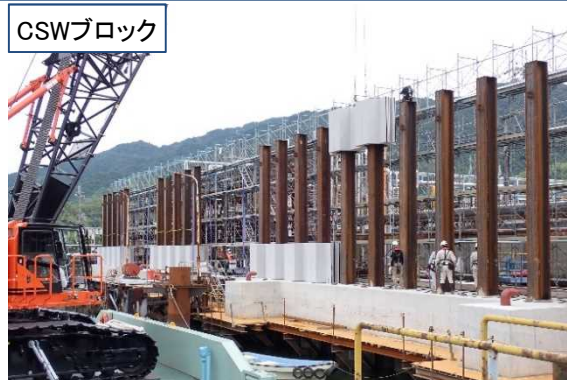
和歌山下津港海岸藤白護岸(第1-2工区)築造工事 【和歌山港湾】
