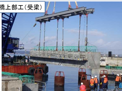
青森港本港地区新中央ふ頭岸壁(-10m)栈橋工事 【青森港湾】
