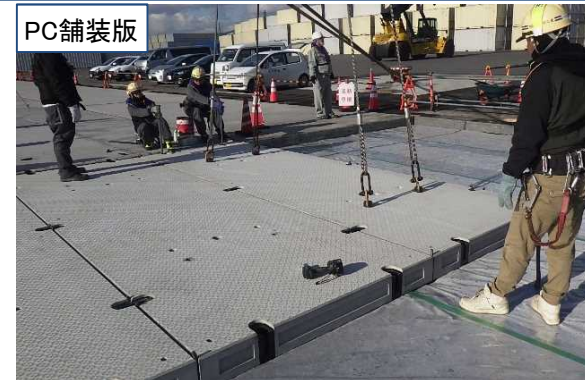
境港外港昭和南地区岸壁(-13m)改良工事 【境港湾空港】
