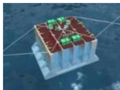
ケーソン据付
