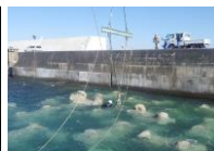
ブロック据付における潜水作業
