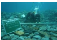
基礎捨石投入における潜水作業
