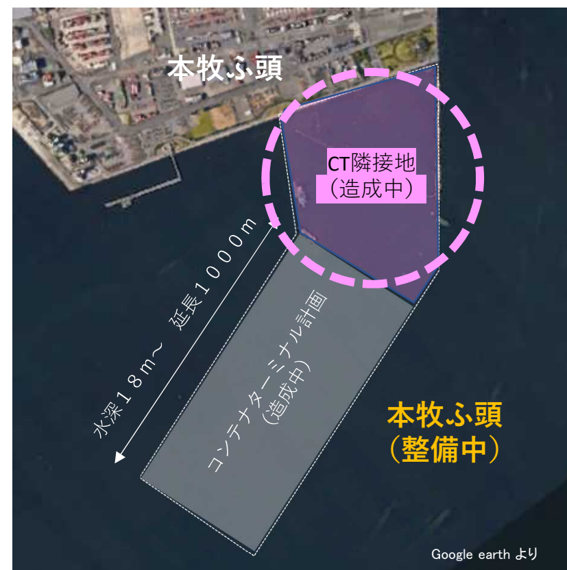
新本牧ふ頭ターミナル予定地の隣接造成地
