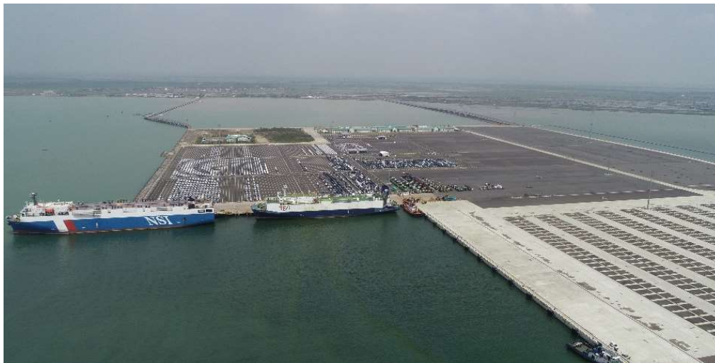
パティンバン港の整備状況 (東亜建設工業提供)
