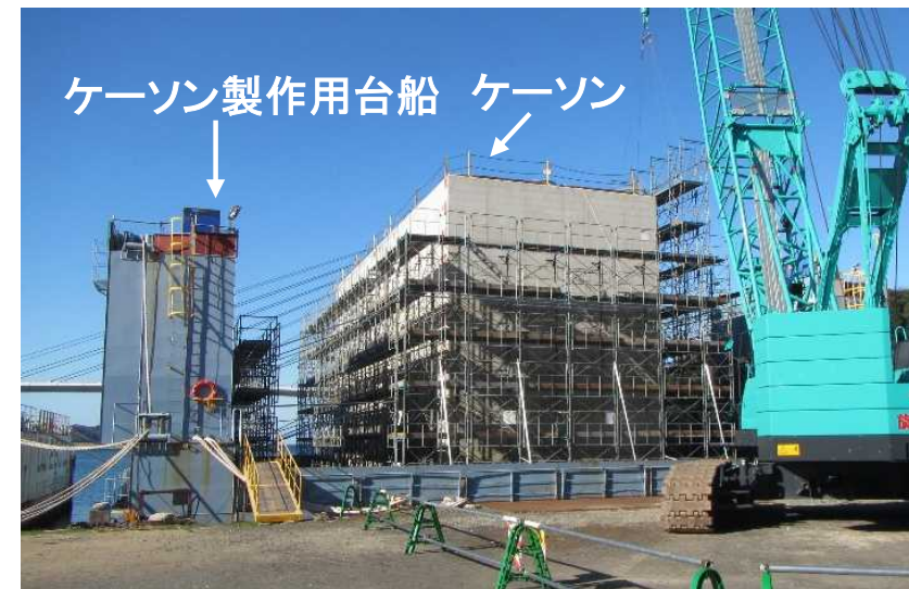
ケーソン製作状況
