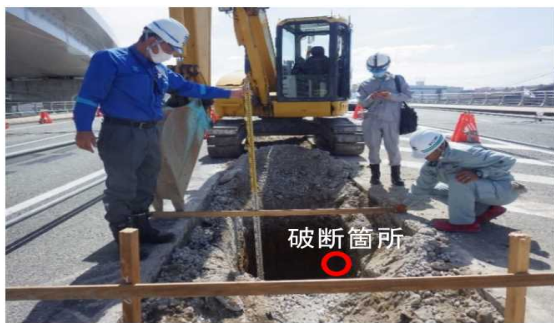
No.79+2 照明灯基礎 掘削作業
