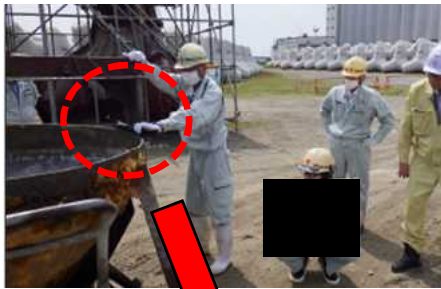
吊具には3cm程度のクリアランスが設けられている 吊具は吊上げ時、吊具に荷重がかかり、接地時は、コンクリートバケットに荷重がかかる
