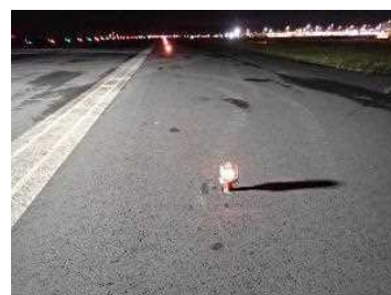
灯火復旧完了状況
