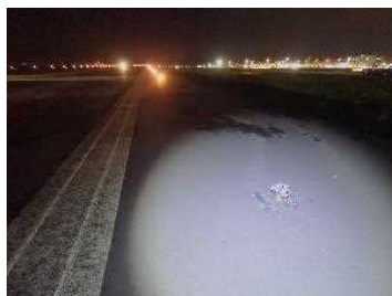
灯火損傷状況
