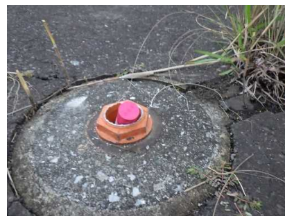
誘導路灯応急復旧完了
