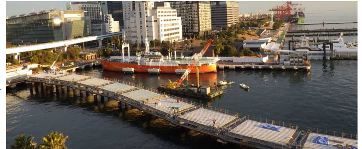
P C 桁架設
