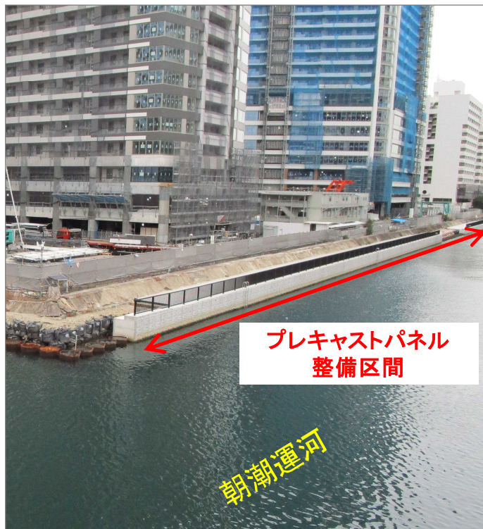
事例 ② 朝潮運河 (勝どき側) 内部護岸工事
