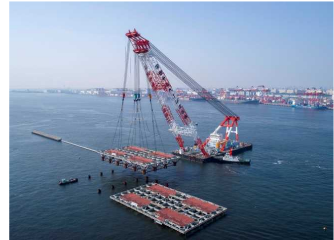
ジャケット据付時
