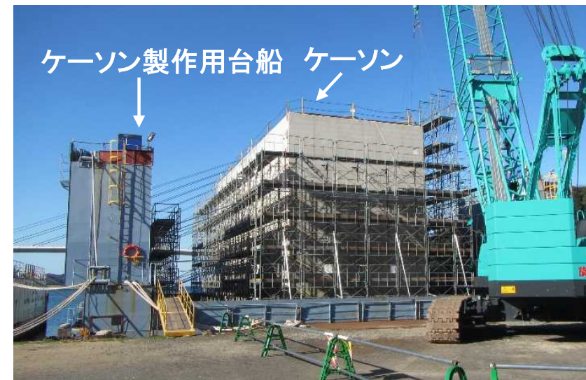
ケーソン製作状況
