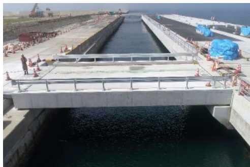
渡橋の架設状況
